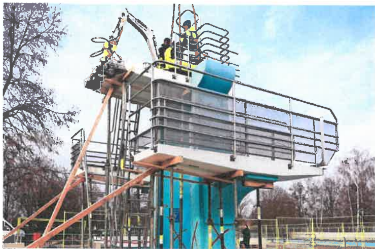
Mit dem Bohrer wird der Sprungturm nach und nach zerbröselt. Foto: factum/Granville
