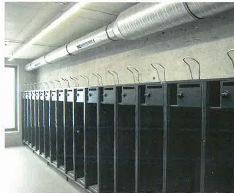
Bild 9: Umkleideschranke vor Infraleichtbetonwand
