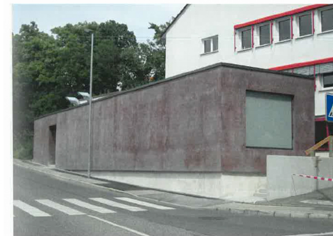
Bild 10: Gesamtansicht mit Feuerwehrgerätehaus im Hintergrund
