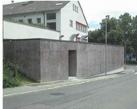
Bild 7: Außenwand nach Abschlussbearbeitung
