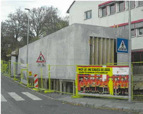
Bild 6: Infraleichtbetonwände im Rohbau
