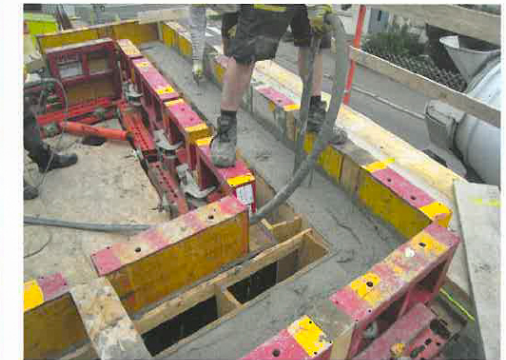
Bild 3: Verdichten des Infraleichtbetons mittels Rüttelstange
