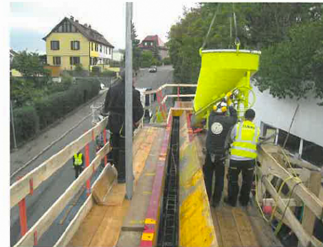
Bild 2: Einbau auf der Baustelle
